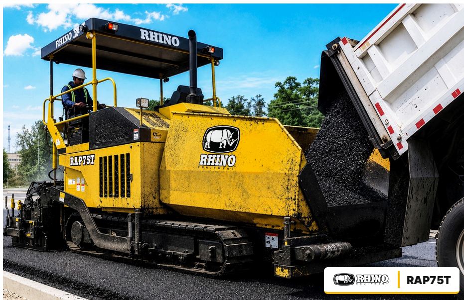
Truck feeding the hopper / Camión alimentando la tolva
